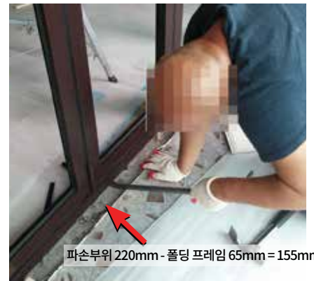
폴딩도어 시공 후 철거부위 확인 ▶
